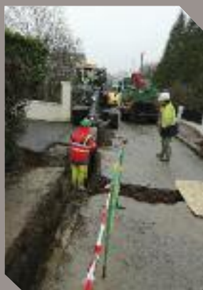
Travaux d'enfouissement des réseaux rue Jules-Renard.
