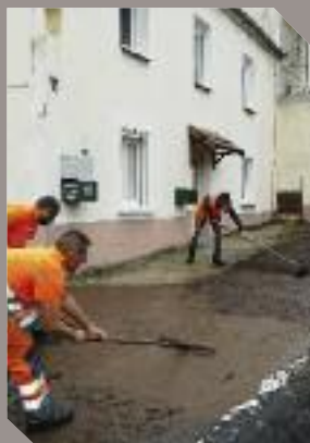
Travaux de revêtements de chaussée rue Deschaumes.
